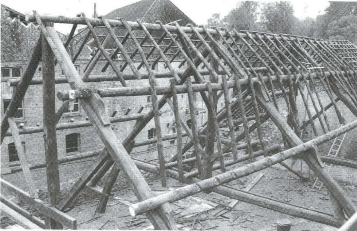
De dakconstructie van de schuur voor de verbouwing van 1999
